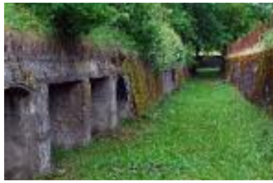
Liebisdorf-Jeuss: à gauche, ouvrage 1914-1918; à droite, mur antichar 1940.
