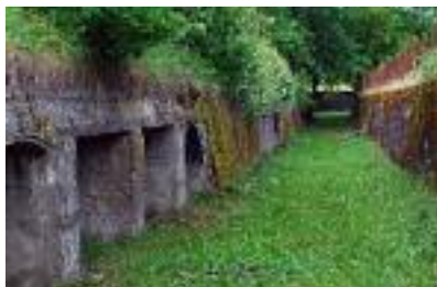
Liebisdorf-Jeuss: Links, Werk 1914-1918. Rechts, Panzerabwehrmauer 1940.
