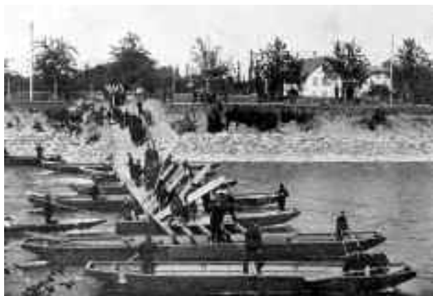
Manœuvres 1903: Construction d'un pont sur l'Aar. ( Souvenirs des manœuvres du 1 er corps 1903 )
